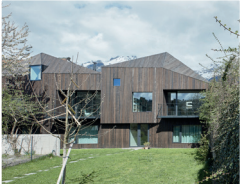
Individualna dvostanovanjska hiša hiša Mut pri Lücke, Innsbruck | Avstrija
