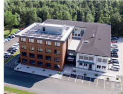
Poslovna zgradba binderholz TimberBrain, Hallein | Avstrija
